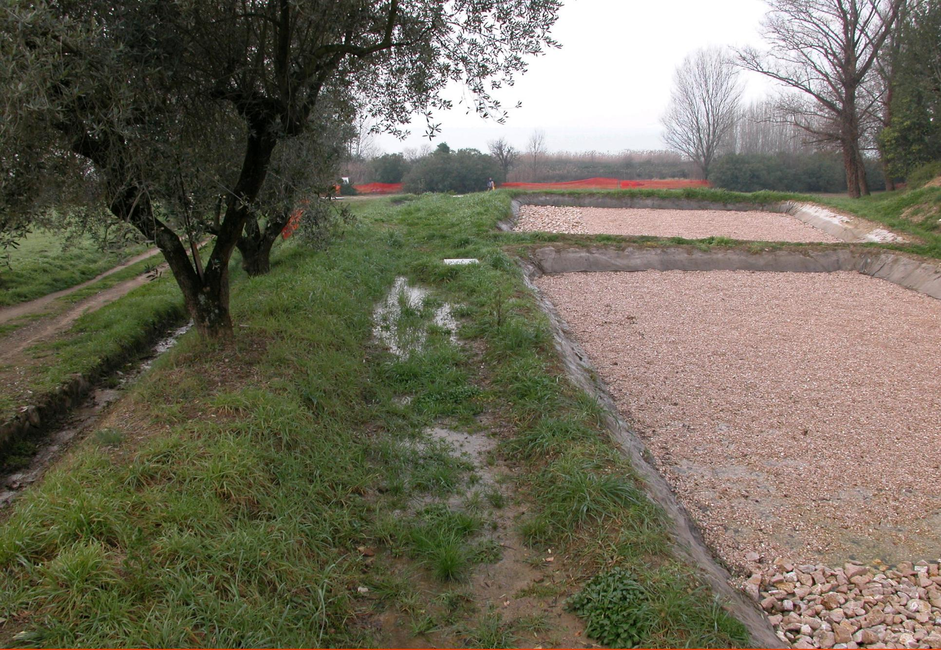
**2) Impianto di fitodepurazione con vasche a sistema a flusso sub-orizzontale**
